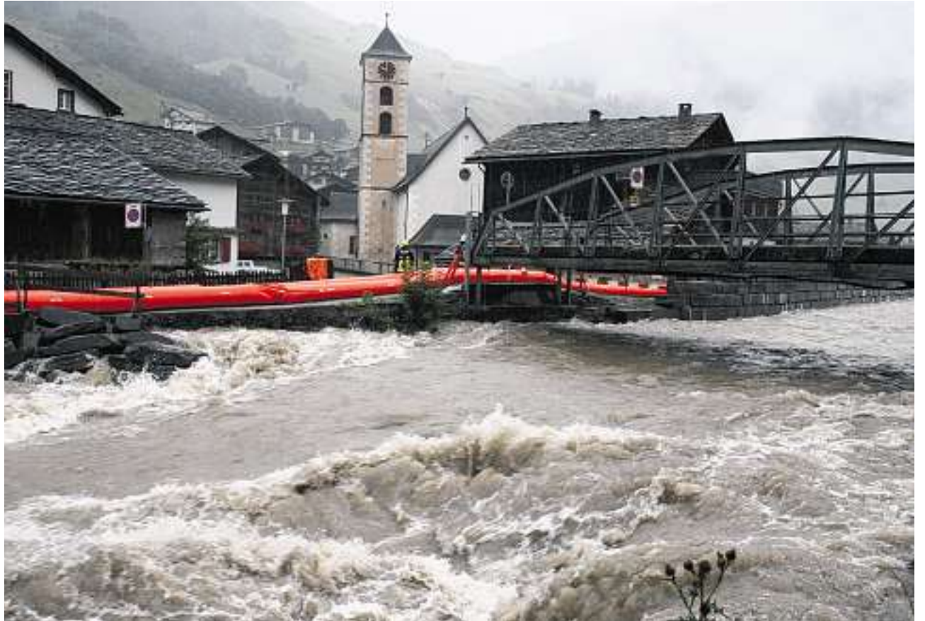
Bedrohlicher Anblick: Die Dorfbrücke von Vals ist wegen den gewaltigen Wassermassen hochgezogen, und die Uferdämme sind mit wassergefüllten Schläuchen zusätzlich gesichert.
